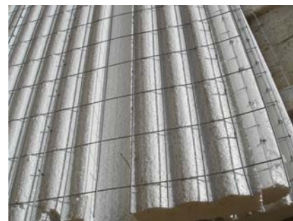
Figure-2(b). M2 Foam slab.
